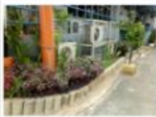
Penggunaan limbah las beton untuk pembatas taman sekitar Gd. C.
