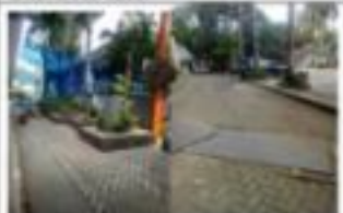
Mini Plaza depan Gd. C dan area parkir sekitar Gd. C dengan lantai Gres Block dan Con Block sehingga air mudah mengalir ke dalam tanah
